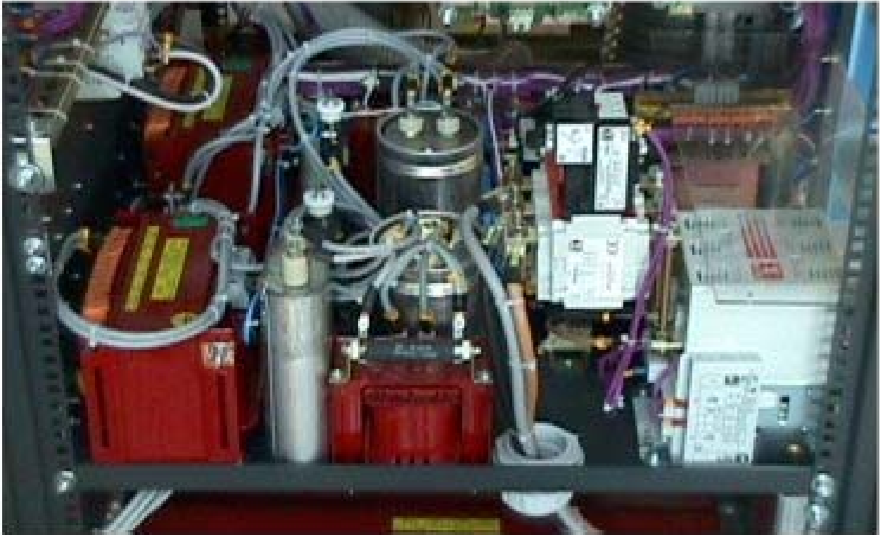
FIG. 31 - VISTA DE REFERENCIA
