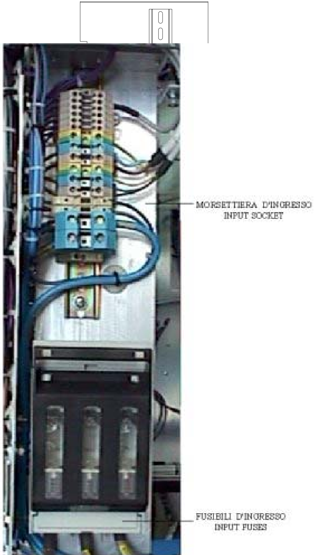
FIG. 41 - ENTRADA DEL ZÓCALO
